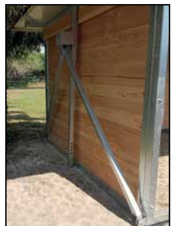
Um Verletzungen der Pferde zu vermeiden, kann die Deichsel nach dem Transport hochgeklappt werden.
