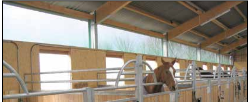
Windnetz-Rollenware - Befestigung mit Holzleisten (bauseits), keine Befestigungsösen enthalten.
