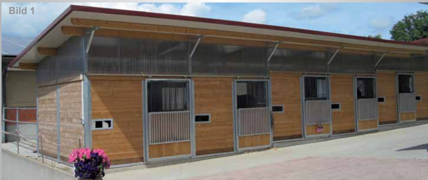
Geräumige, helle Außenboxen mit Schiebetüren und Douglasienholz
