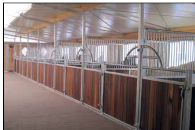
Pferdeboxen „Arizona“ mit Denya-Hartholz und Trennwänden „Standard“
