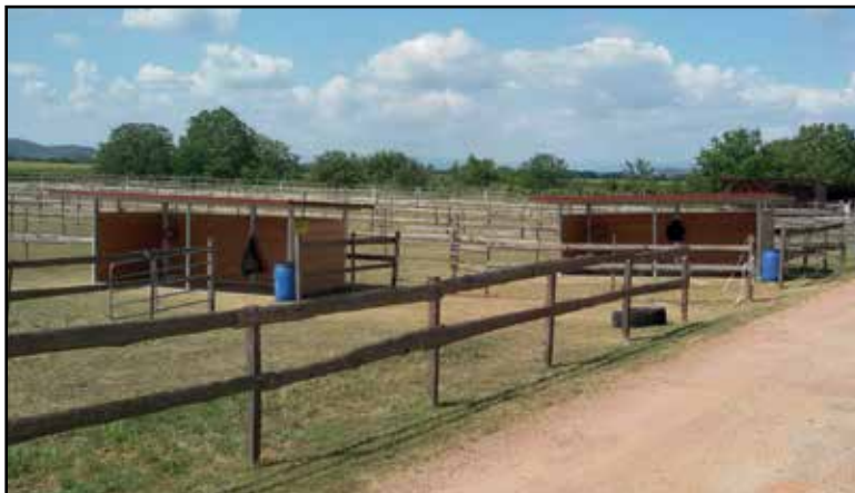
Weidehütten mit Sandwich-Dacheindeckung (isolierend) gegen Aufpreis. Die Isolierung schützt besonders vor Wärmestau im Sommer.
