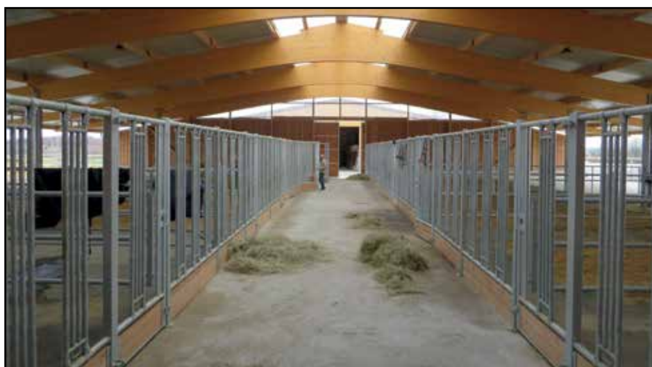
Laufställe mit Sicherheits-Durchfressgitter und Teleskopabtrennungen
