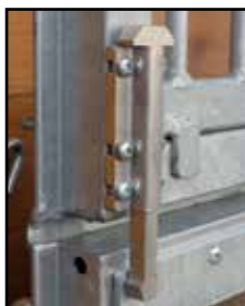
Verbindungsriegel (Oberflügel / Unterflügel)
