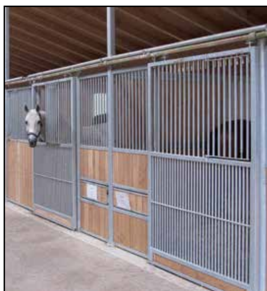
Schiebetüren mit Gitter im unteren Teil zur besseren Belüftung
