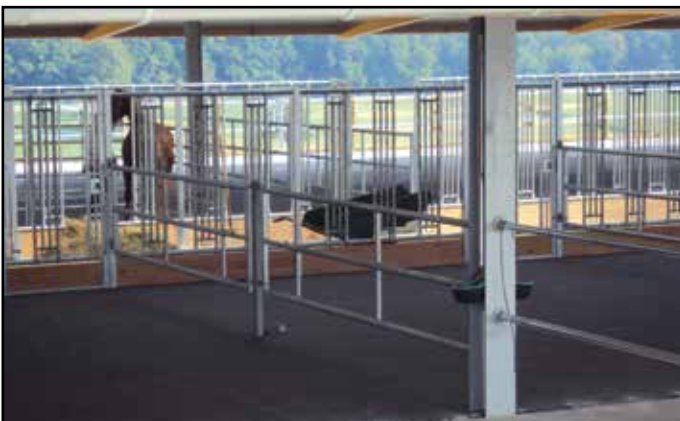
Buchtenabtrennungen aus Teleskoptüren
