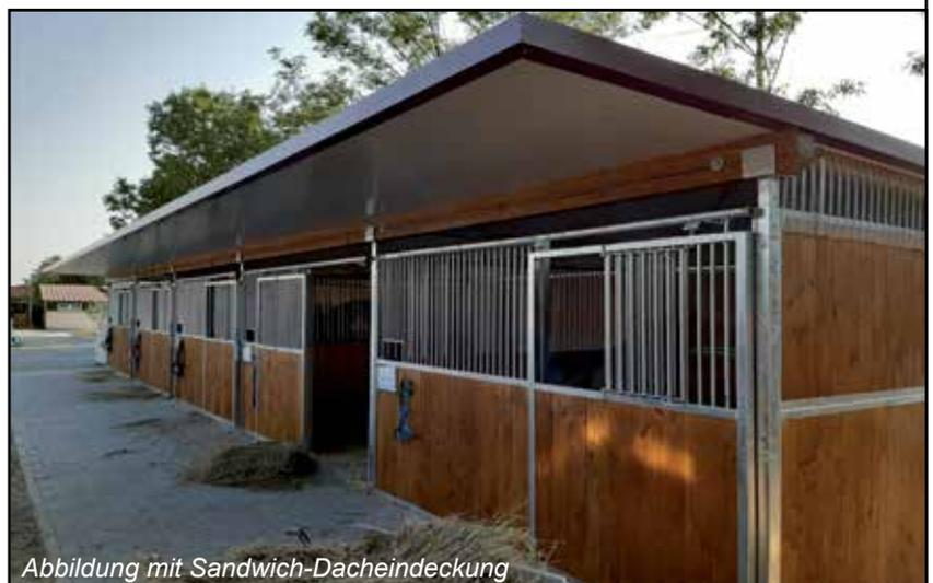
Abbildung mit Sandwich-Dacheindeckung
