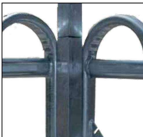
Bis auf den Boden durchgehende Vierkantpfosten für optimale Standfestigkeit
