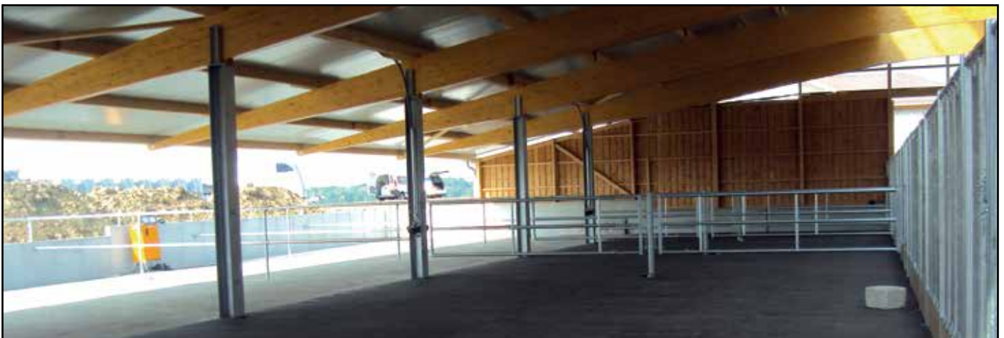
Laufstall mit großem Liegebereich und Buchtenabtrennungen aus Teleskoptüren
