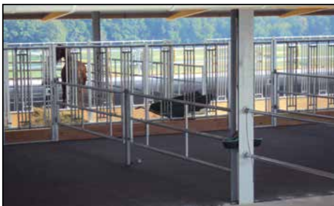
Buchtenabtrennungen aus Teleskoptüren
