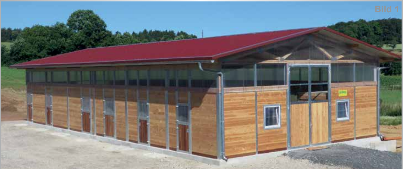
Freitragender Stall mit Nagelbindern
