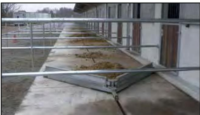
Es ist nicht erforderlich, eine Aufkantung zu betonieren. Eine ebene Fläche (Beton / Pflastersteine) mit einer einbetonierten U-Führungsschiene reicht aus.
